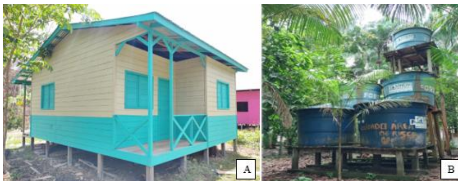
Figura 2: Casa do programa Crédito Instalação e habitação (A) e infraestrutura do sistema de captação e distribuição de água do programa Sanear Amazonas (B), na Resex Médio Juruá, Amazonas, Brasil, 2022. Fonte: Gestor local da Resex Médio Juruá.
